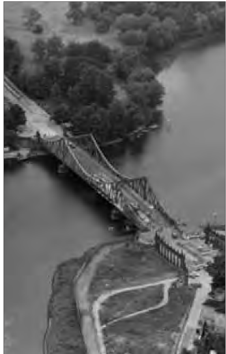
Luftaufnahme der Glienicker Brücke Quelle: BStU, MfS, ZKG, Nr. 8410, Bl. 37.
